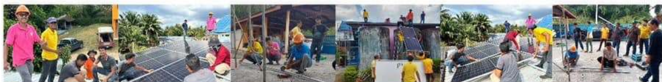
อบรมช่างโซลาร์เซลล์ท้องถิ่น ภาคปฏิบัติการ ติดตั้งโซลาร์เซลล์ ณ รพ.สต.คลองยาง อ.เกาะลันตา จ.กระบี่
